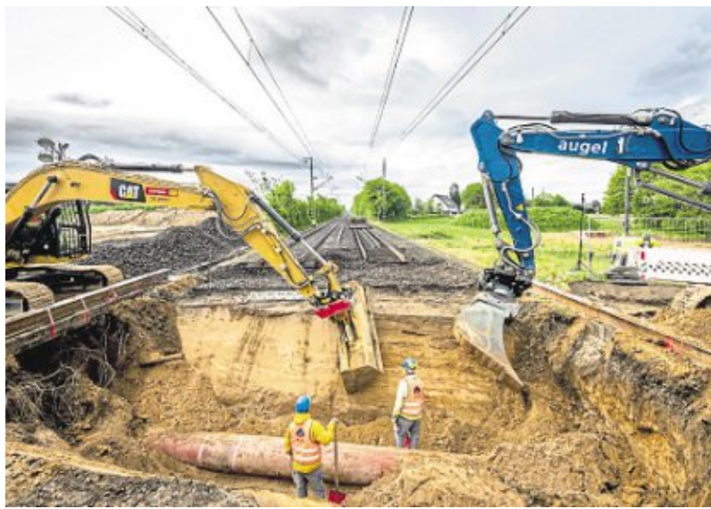
In Vörde (Niederrhein) hält die Augel GmbH die Pipeline instand.
